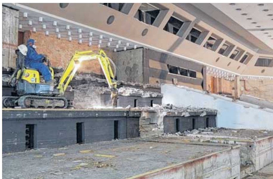
Mit Pressluftschlämmern arbeiten sich kleine Bagger durch die Zuschauertribünen des Großen Saals. Fotos (2): Uwe Hofmann
